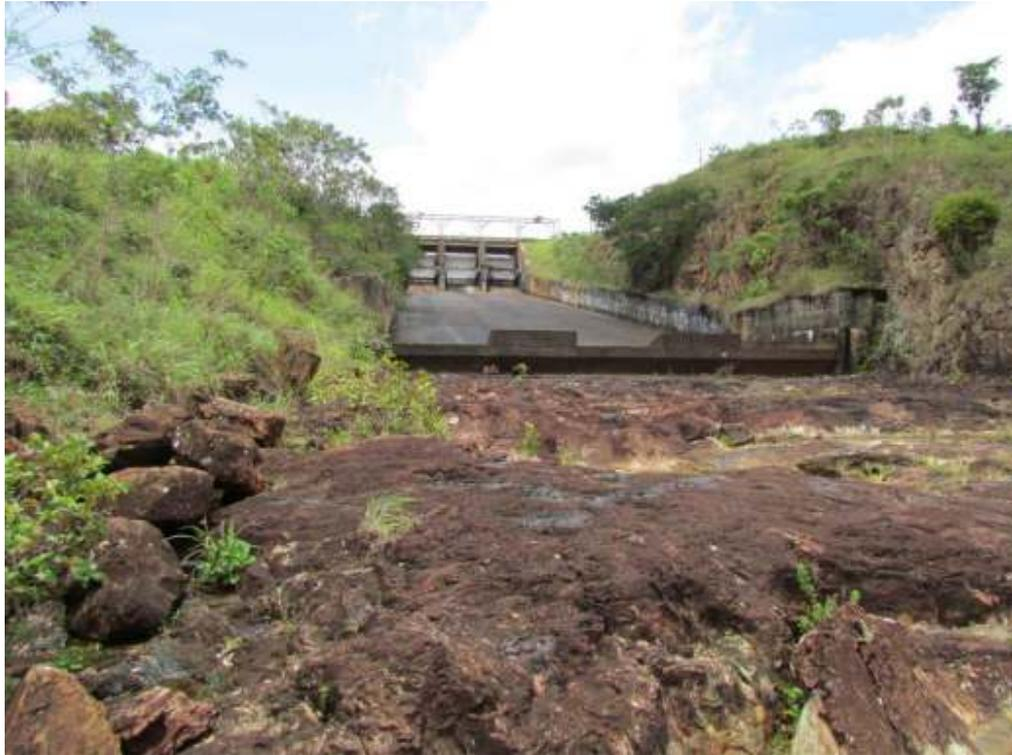
**Figura 18. Região de dissipação da água do vertedouro da PCH Paranoá.**
