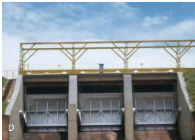
**Figura 17. Vãos do vertedouro (E) e Paramento jusante da comporta segmento (D)**
