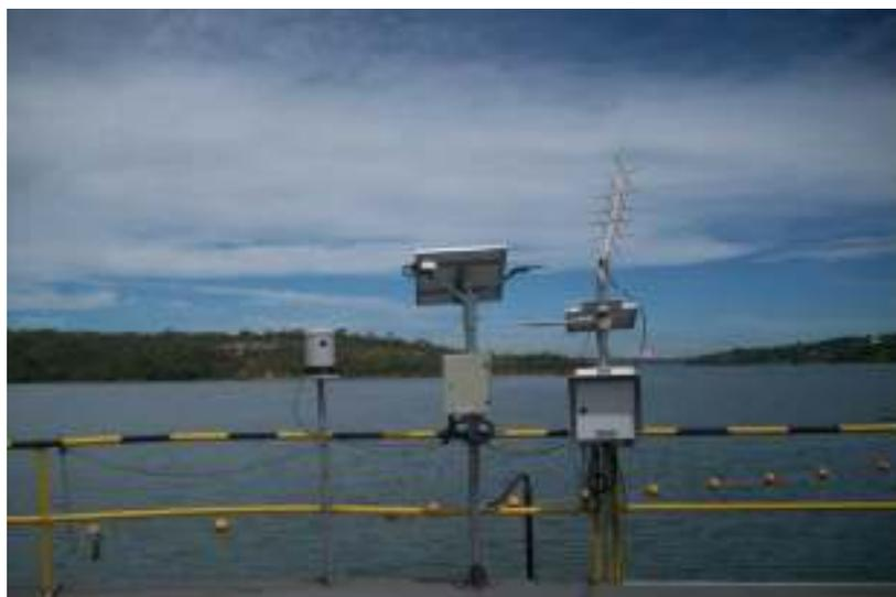
Figura 19. Estação telemétrica instalada no barramento da PCH Paranoá.
