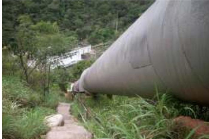
**Figura 12. Tubulação do Conduto Forçado.**
